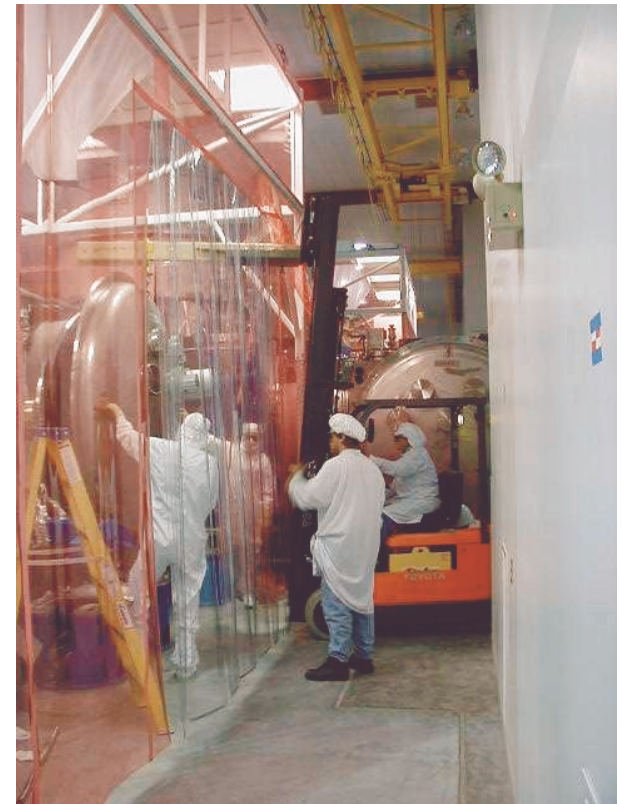
HAM Door Removal (Hanford 4km)
